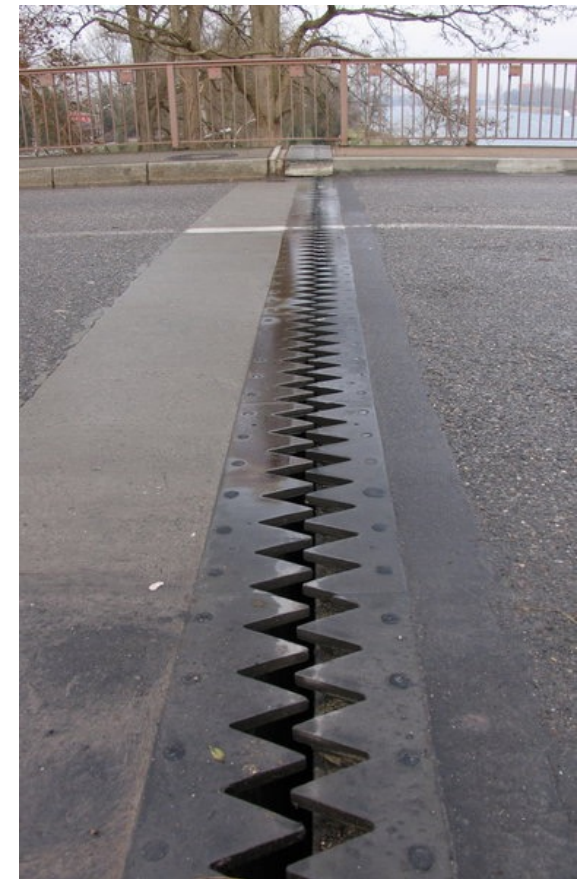
Joint de dilatation thermique d'un pont
